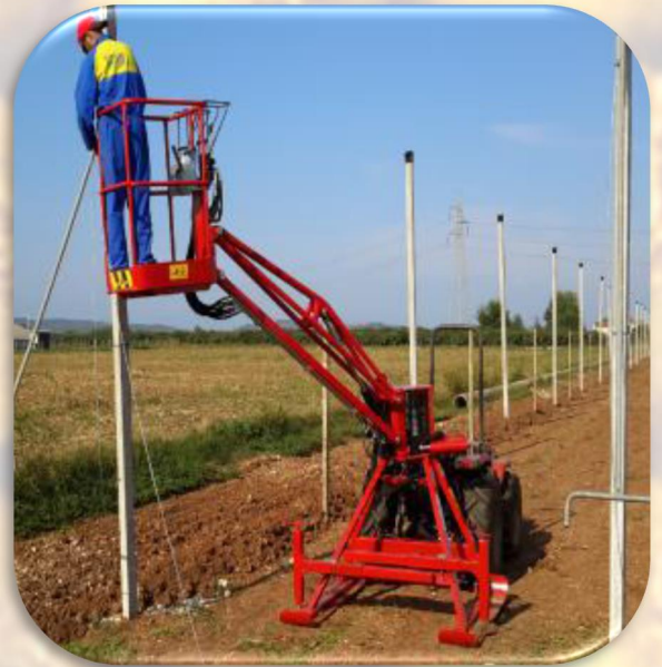
TR1K utilizzato per la manutenzione di nuovi impianti
